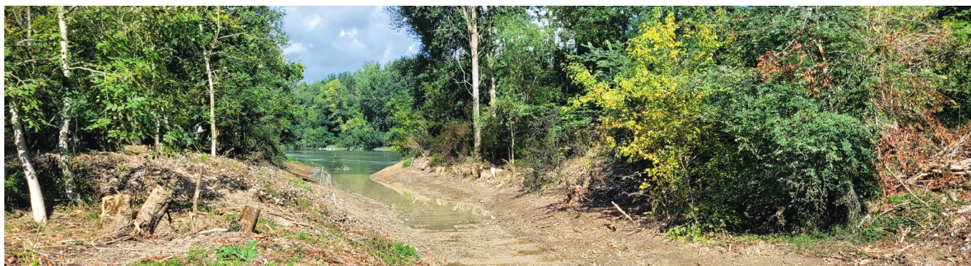
Annexe reconnectée - après travaux (site de l'Île Doumerc-Garonne)
