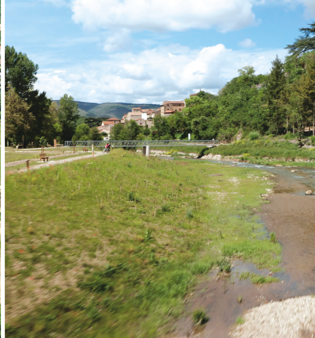
Les berges du Cernon reprofilées sur la Zone d'Expansion de Crues de Saint-Georges-de-Luzençon, ©SMBVTAM
