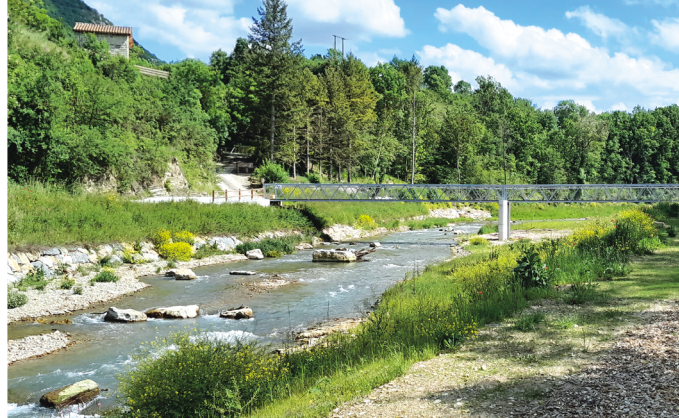
Effacement du seuil pendant et après les travaux
