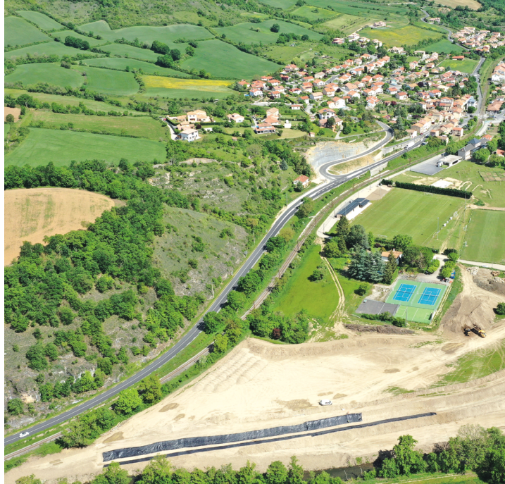
Chantier de restauration en cours sur la ZEC de St Georges de Luzençon
