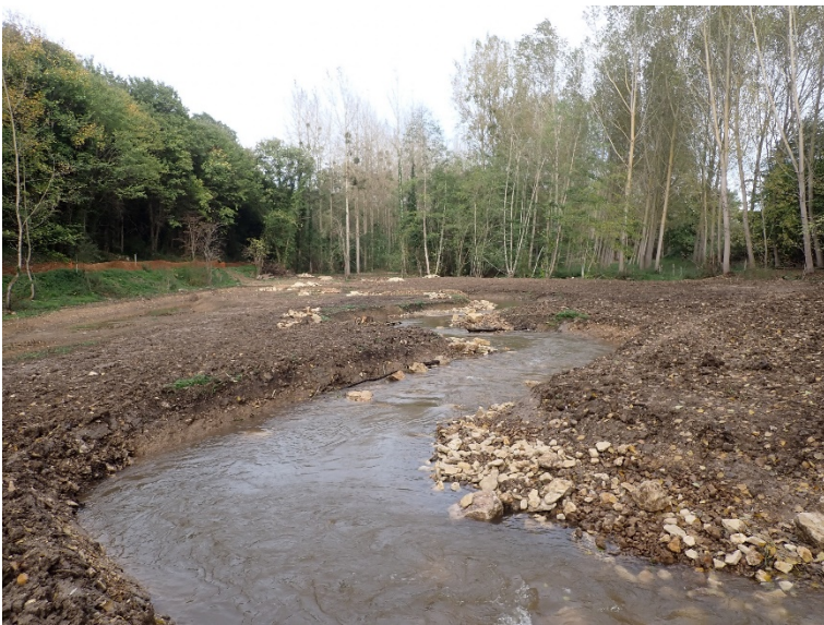
Rivières de contournement de bief en remplacement d'un seuil infranchissable création ex nihilo
