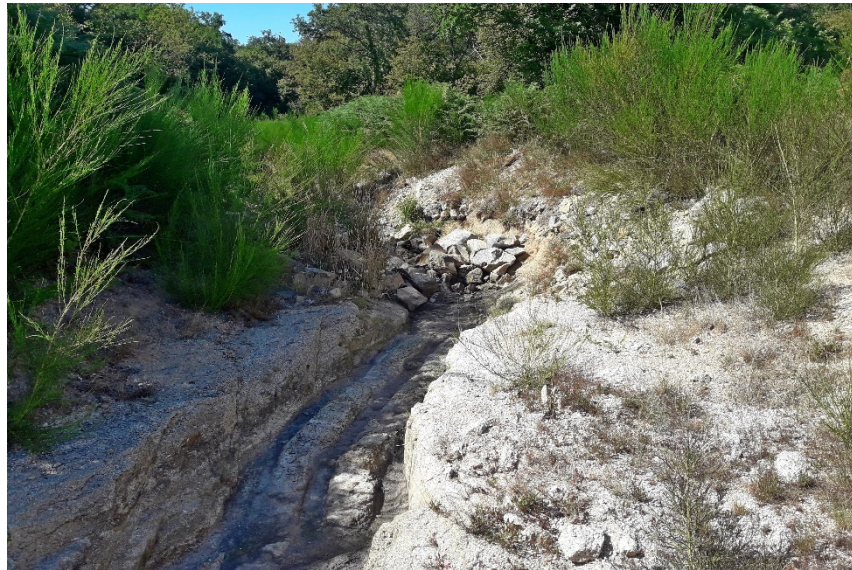
Pente trop forte (mauvaise répartition amont-aval)
