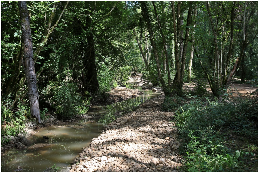
Resserrement d'un bief de moulin trop large (avec meilleure répartition des débits vers la rivière).
