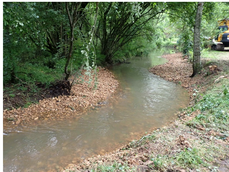
Rivières de contournement de bief en remplacement d'un seuil infranchissable création ex nihilo
