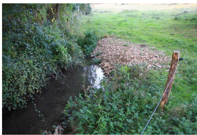
Protection souple de berge érodée
