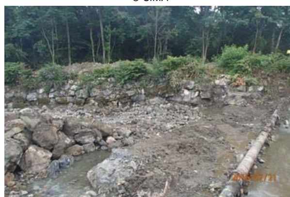
Pendant les travaux de démantèlement du seuil en 2016 © SIMA
