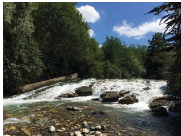
Seuil de protection de la conduite en 2015 avant travaux © SIMA
