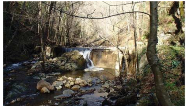
Seuil Inchaya en 2016 avant travaux © fédé pêche 64
